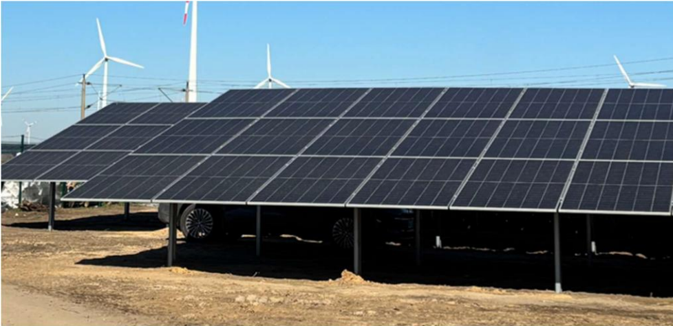
Abbildung 2: Objektbeispiel – Auf Acker errichtete Modultische vor Einbringung der Begrünung
