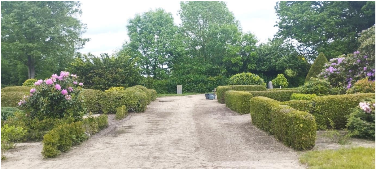
Der Hauptweg wird mit Rumpelpflaster gepflastert und bietet Standorte für die Staudenbeete sowie die Baumallee
